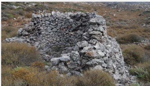
Un four assez bien conservé. On observe un renflement à sa base, sans doute pour augmenter la stabilité de l'ouvrage.
